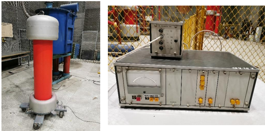
Fig. 11 – Divizorul capacitiv și voltmetrul de vârf utilizate
